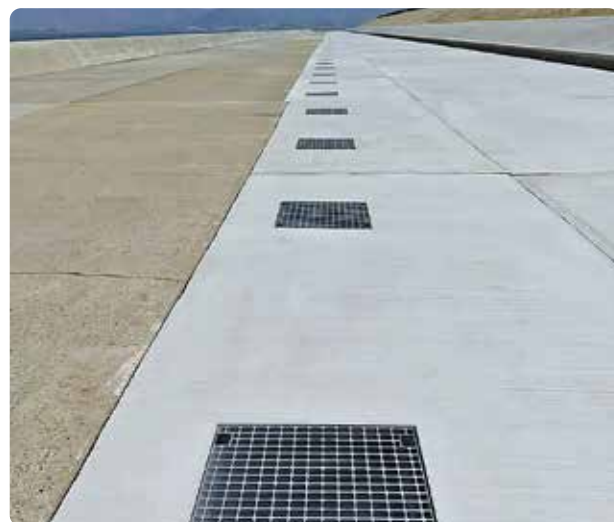
山口県 2021年施工
