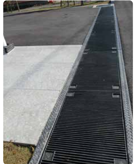
ケンボージングボルト固定 (Zアングル)
