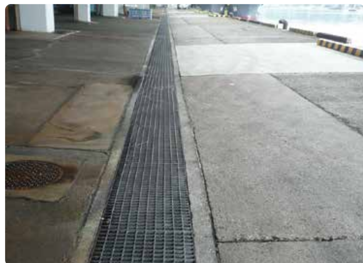
山口県 2012年施工
